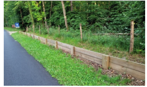
Barrière de protection le long d'une route
